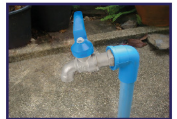
3. หมุนก๊อกน้ำตามเข็มนาฬิกา เข้ากับท่อเปิดวาล์วน้ำ สำหรับใช้ก๊อกน้ำ
