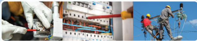
ใช้งานร่วมกับถุงมือหนังสวมทับถุงมือกันไฟฟ้า
